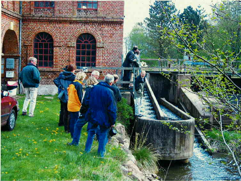
Fischtreppe und Faunapassage an der Søbyvad Mühle bei Hammel
